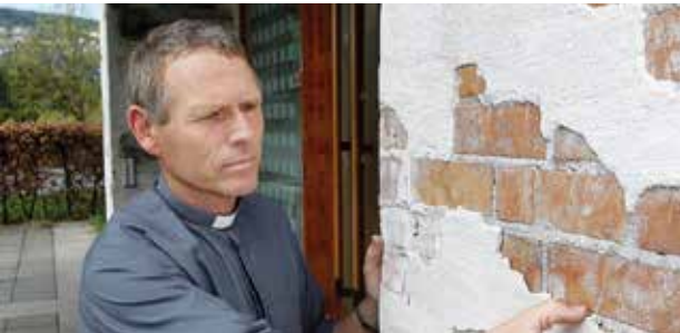
Lommedalen kirke viste tidlig tegn på forvitring knyttet til fukt og frost, som sokneprest Knut Grønvik peker på her. Bildet er fra Budstikkas reportasje om saken før biskopen kom på besøk våren 2013. Foto: Karl Braanaas
